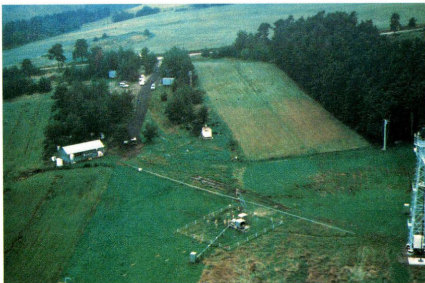
Fig. 9. — Vue générale de la station de Saint-Privat-d'Allier, avec, à droite, le pylône de 26 mètres de haut (doc. EdF).
