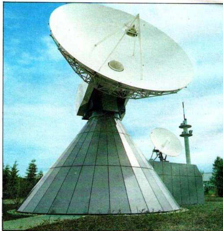
Les deux antennes de la station terrienne de la Deutsche Bundespost à Usingen. L'antenne de 13,5 m de diamètre possède 6 voies d'émission dont quatre sont opérationnelles, et deux voies d'émission de remplacement. Les amplificateurs de puissance propres à ces voies d'émission sont munis de tubes à ondes progressives de 300 W.
