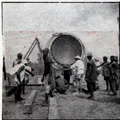
Le radio-télescope de 3,2 m de longueur d'onde en cours d'installation, à Markala, en août 1951.
