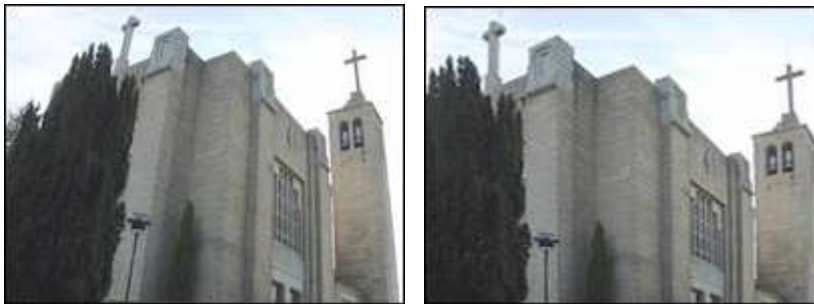
Redressement des lignes de fuites.
